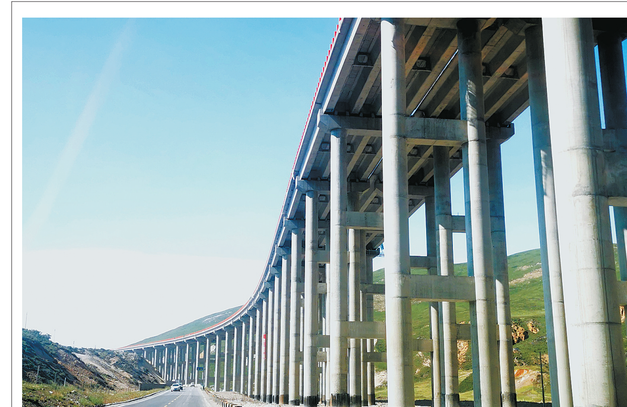
8月8日，我省重点建设项目扁门高速景阳岭隧道、小西沟大桥等正在加紧建设。扁门高速(门源至扁都口)路线全长150.08公里，于2019年7月开工建设，此高速是国家高速公路网中G0611张汶公路的一段，也是我省联通甘肃河西走廊的重要出省大通道，预计部分高速年底建成通车。 本报记者 祁国彪 摄
